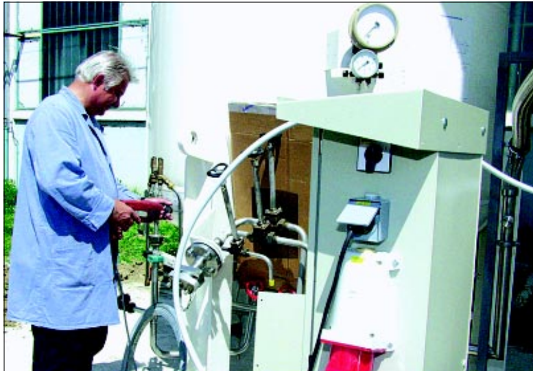
Montaža spremnika za tekući dušik
